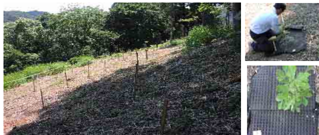
図 1 3 愛知県森林・林業センター内の試験施工
