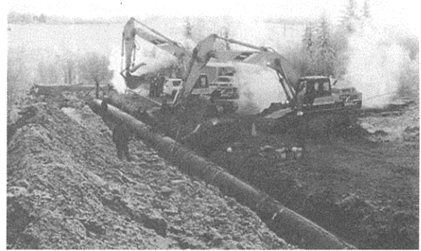
写真1 パイプライン埋設状況
